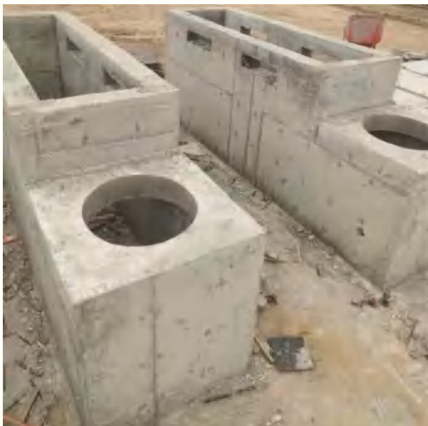
图2 环网柜基础施工工艺图
