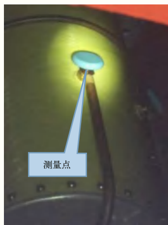
图2 对外筒壁引线连接端子处进行测量
