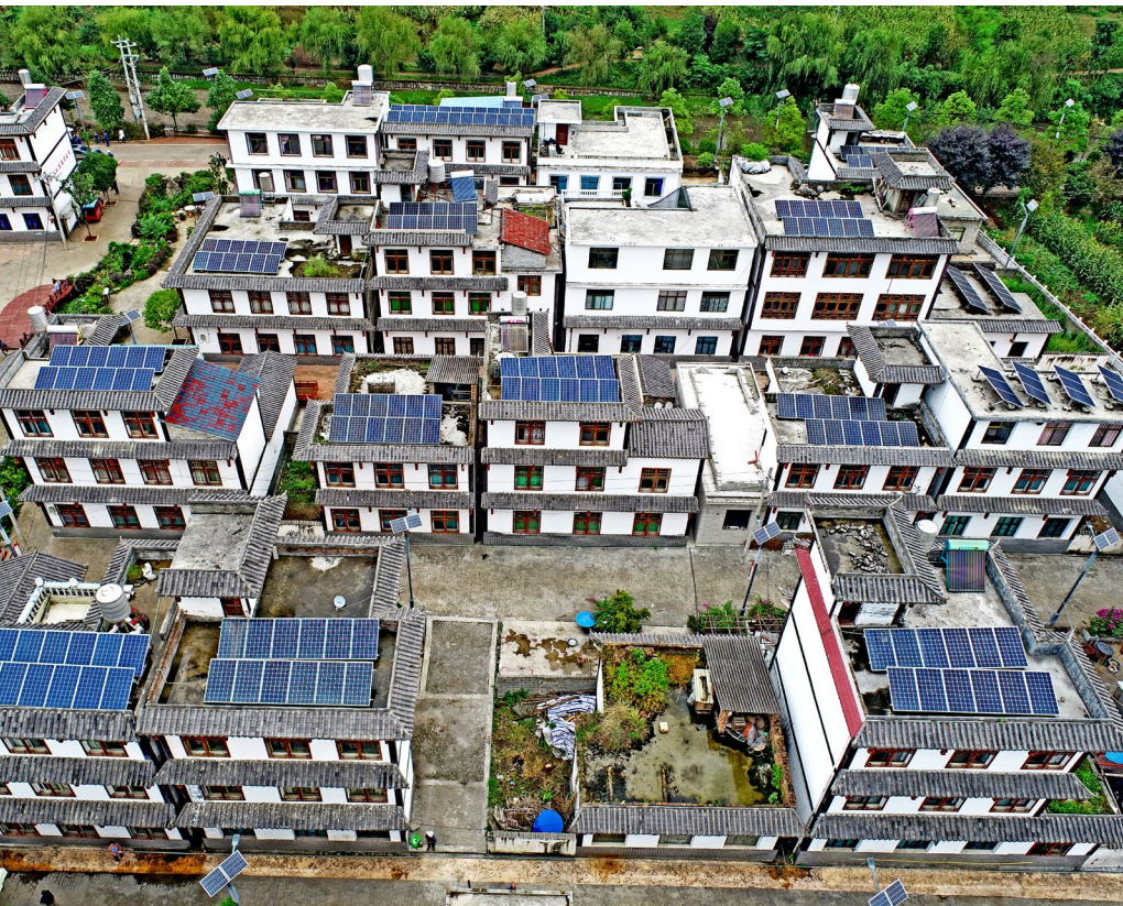
贵州六盘水盘州市羊场乡纳木村村民楼顶普遍安装了光伏发电设备/钱东生 摄
