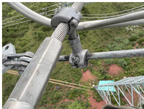
图12 调距间隔棒现场安装位置图
