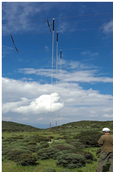
图 2 相间间隔棒和防跳跃装置
