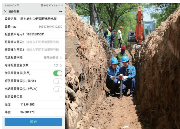
图3 基于单防区振动光纤的高压电缆防外破监测预警装置的微信信息推送
