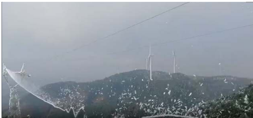
图 1 风电场导线整档脱冰反复弹跳图片
