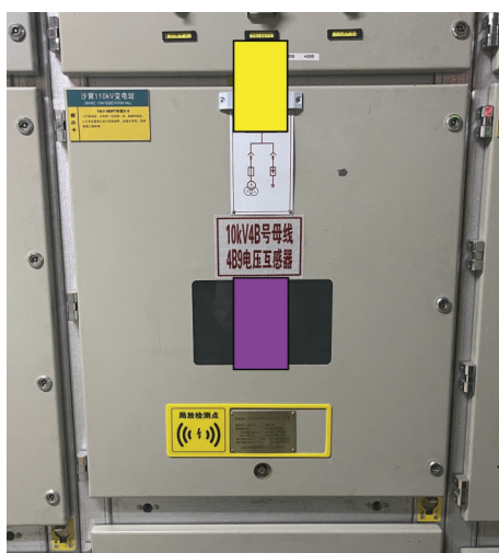
图 11 4B9/4B8 前中柜窗与前中上柜缝探头位置
