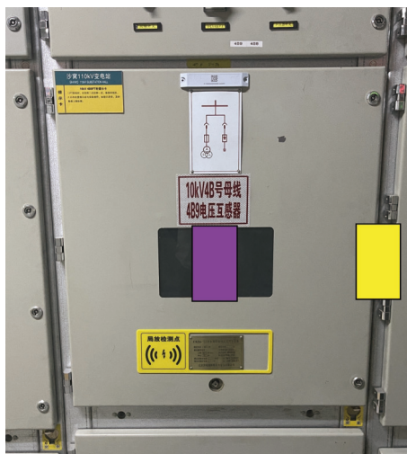
图9 4B9/4B8前中柜窗与右柜缝探头位置
