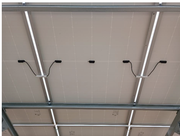
图2 光伏组件连接器现场固定方式
