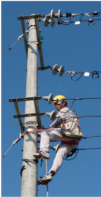
“雨露计划”员工进行登杆作业实训
