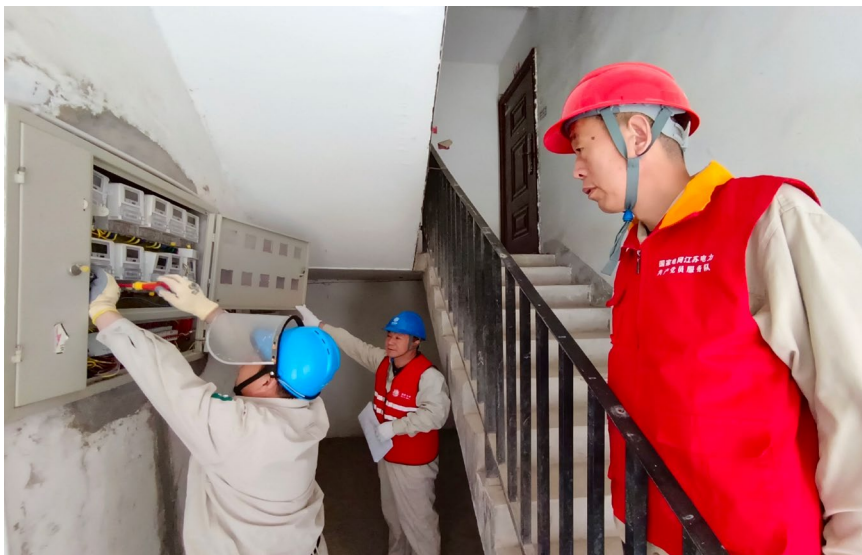
上塘供电所党支部书记郭崇喜在10千伏上北164线3#变表计安装现场，开展施工安全督导
