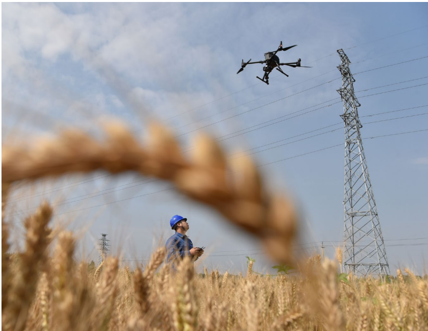
国网高密市供电公司彩虹共产党员服务队队员在麦田利用无人机巡视110千伏线路
