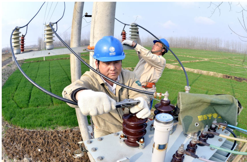
天泉湖供电所员工检修配电台架
