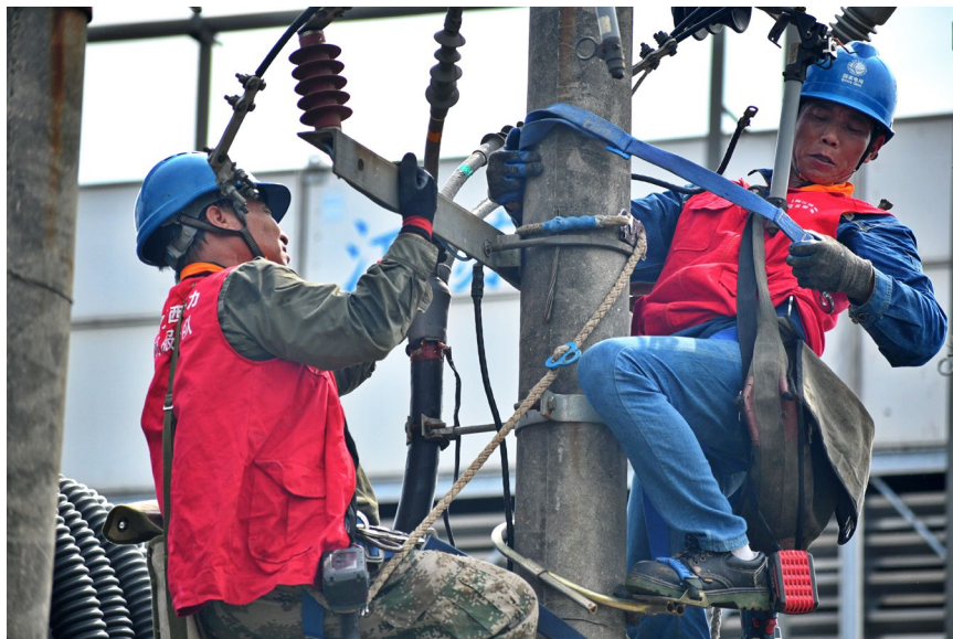
抢修受损线路
