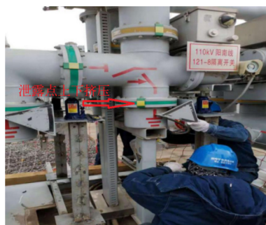
图5 检修人员更换法兰绝缘子
