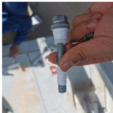
图 1 固定螺栓缠绕生料带
