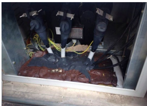
图2 柔性绝缘防水材料封堵处理后的现场图
