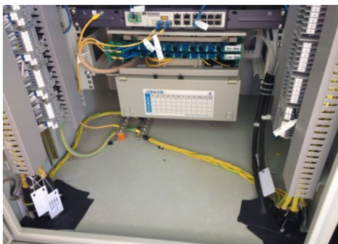
图2 柔性绝缘防水材料封堵处理后的现场图
