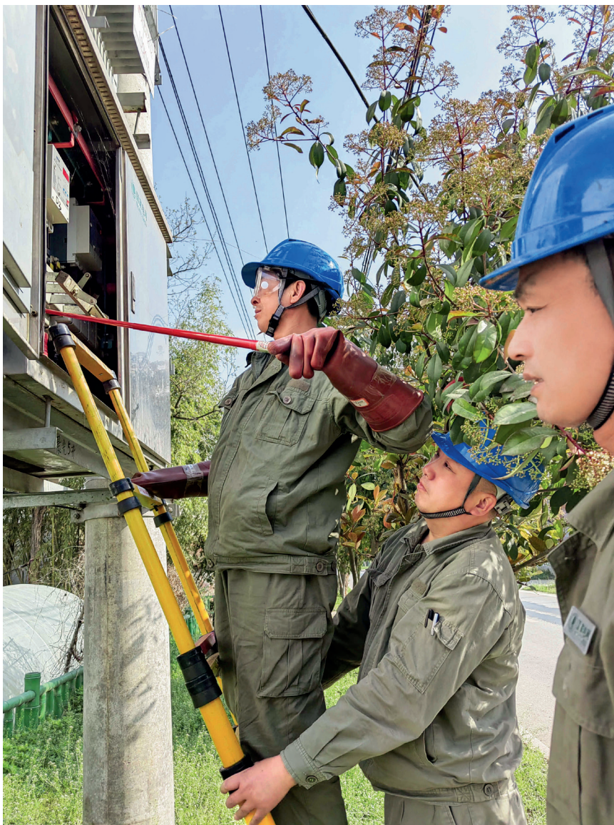
供电员工在抽水抗旱台区开展工作
