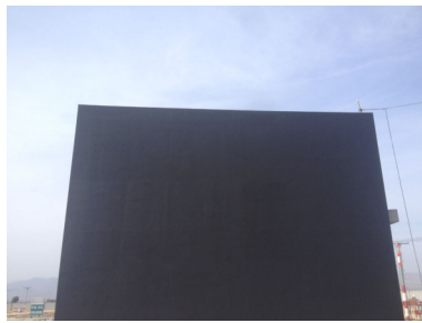
图 2 建筑外墙封闭底漆图
