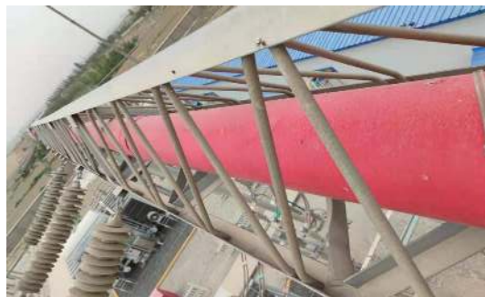
图 8 变电站门型构架防鸟筒检查
