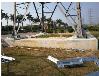
图6 铁塔基础添加连梁的工程应用
