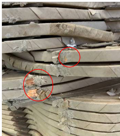
图 7 A 相中压绕组绝缘损坏情况
