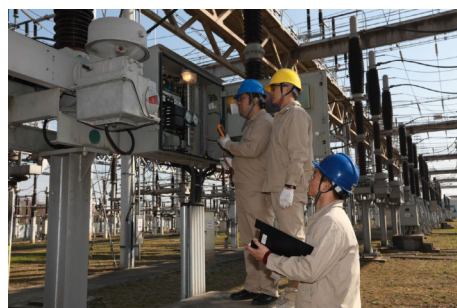
图 6 断路器在线监测装置的现场安装
