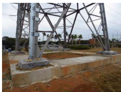
图 3 夹具加固铁塔
