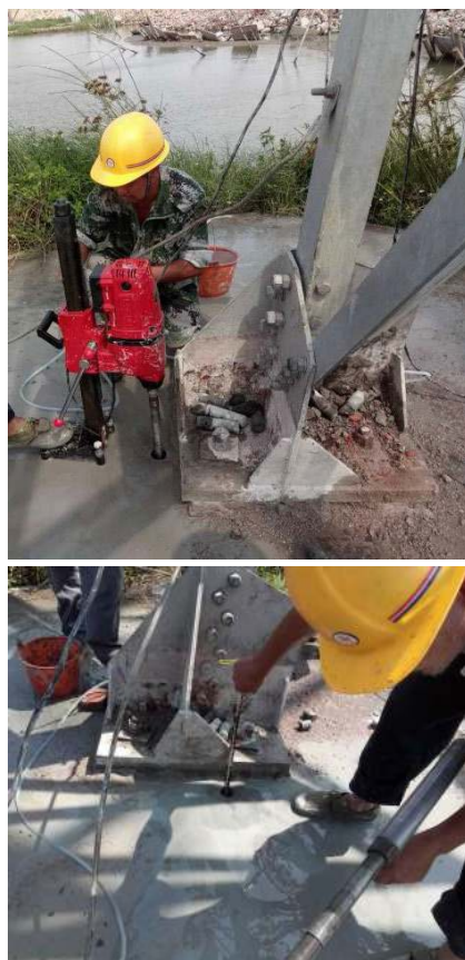
图 4 基础连接加固现场
