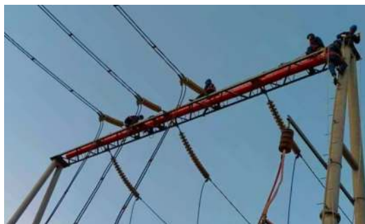
图 7 变电站门型构架防鸟筒现场安装
