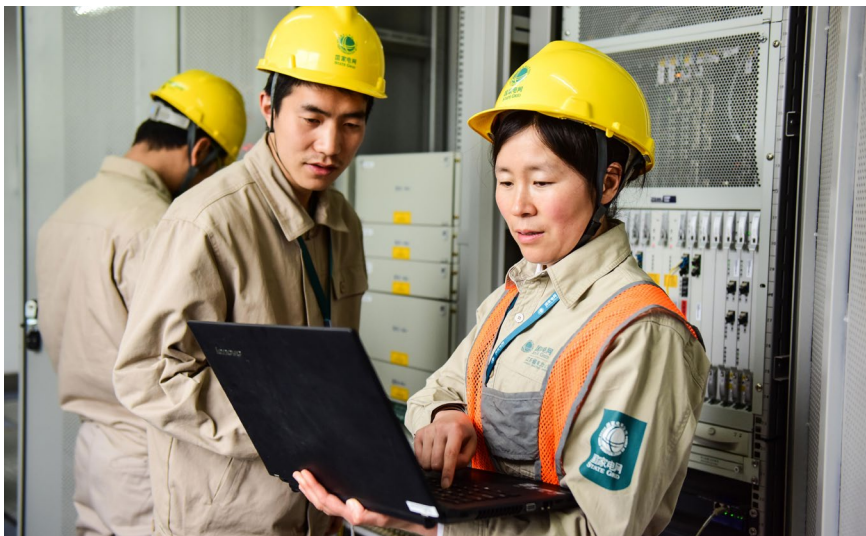
吉兰芳(右一)在110千伏工农变施工作业 / 梁德斌 摄
