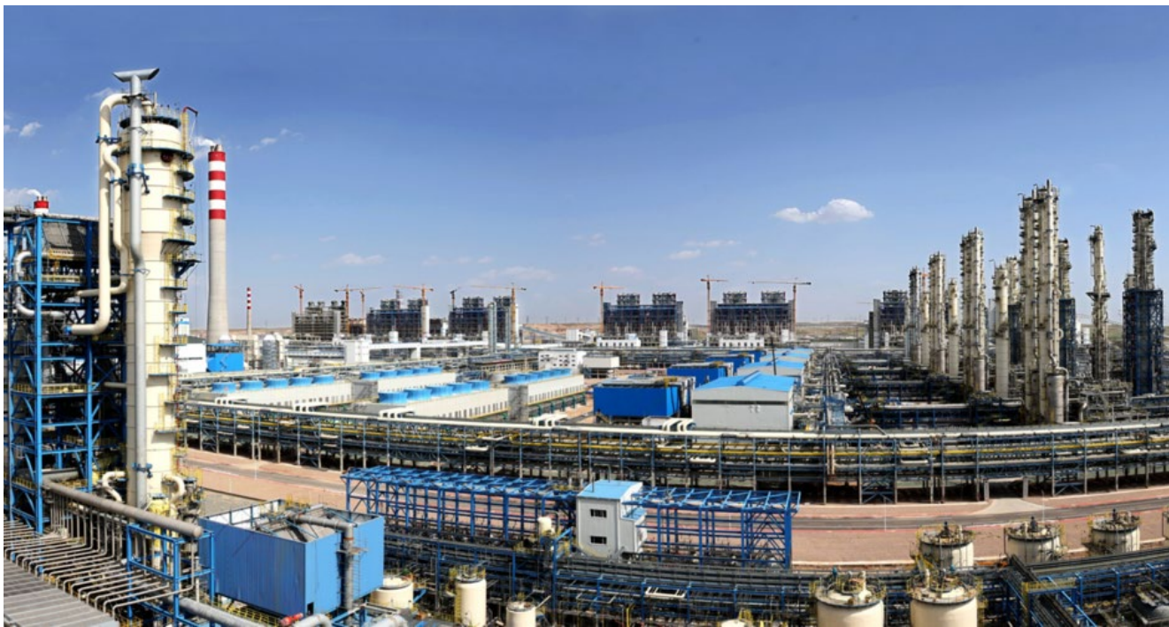
宁东煤炭基地
