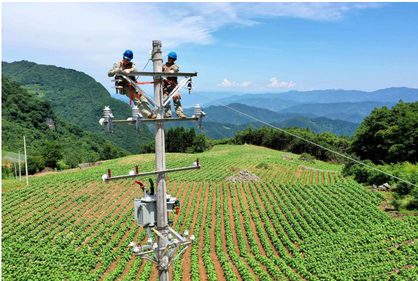
湖北襄阳南漳10千伏景55薛景联线寺冲村4组台区新建工程施工现场
