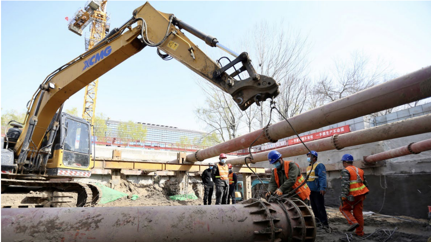
电力施工现场
