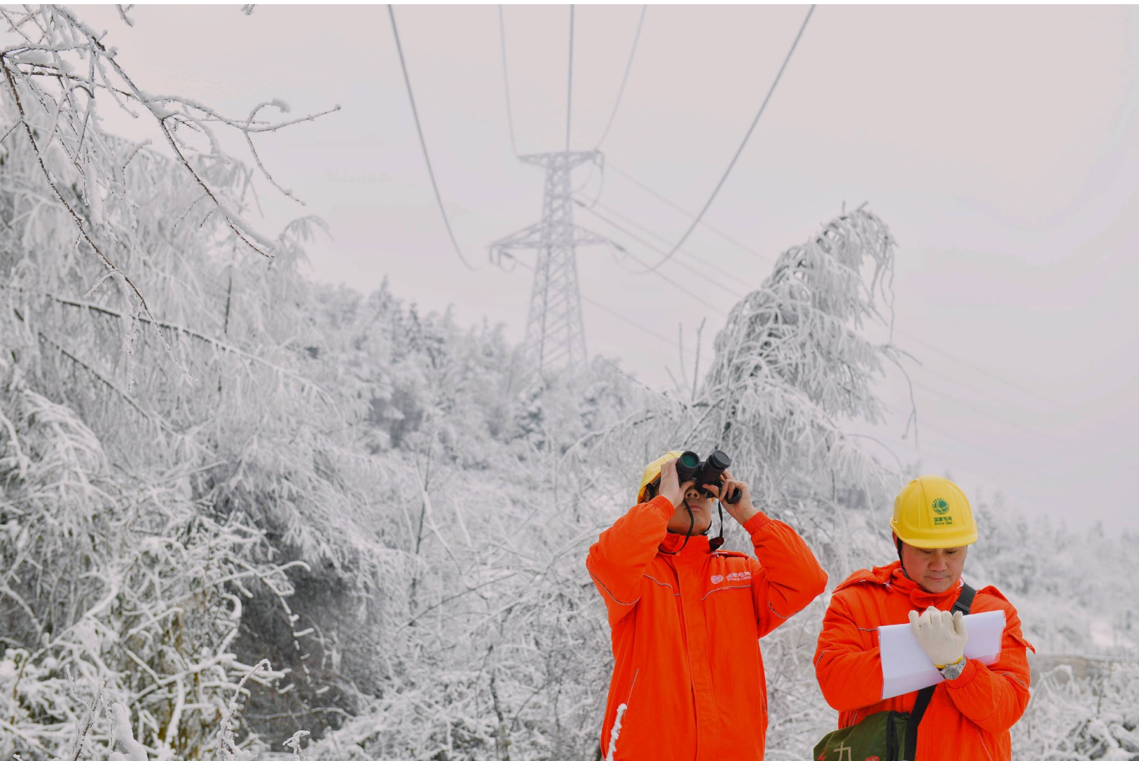
国网重庆丰都供电公司工作人员正在对110 kV坝丰线进行巡检/图 崔 力
