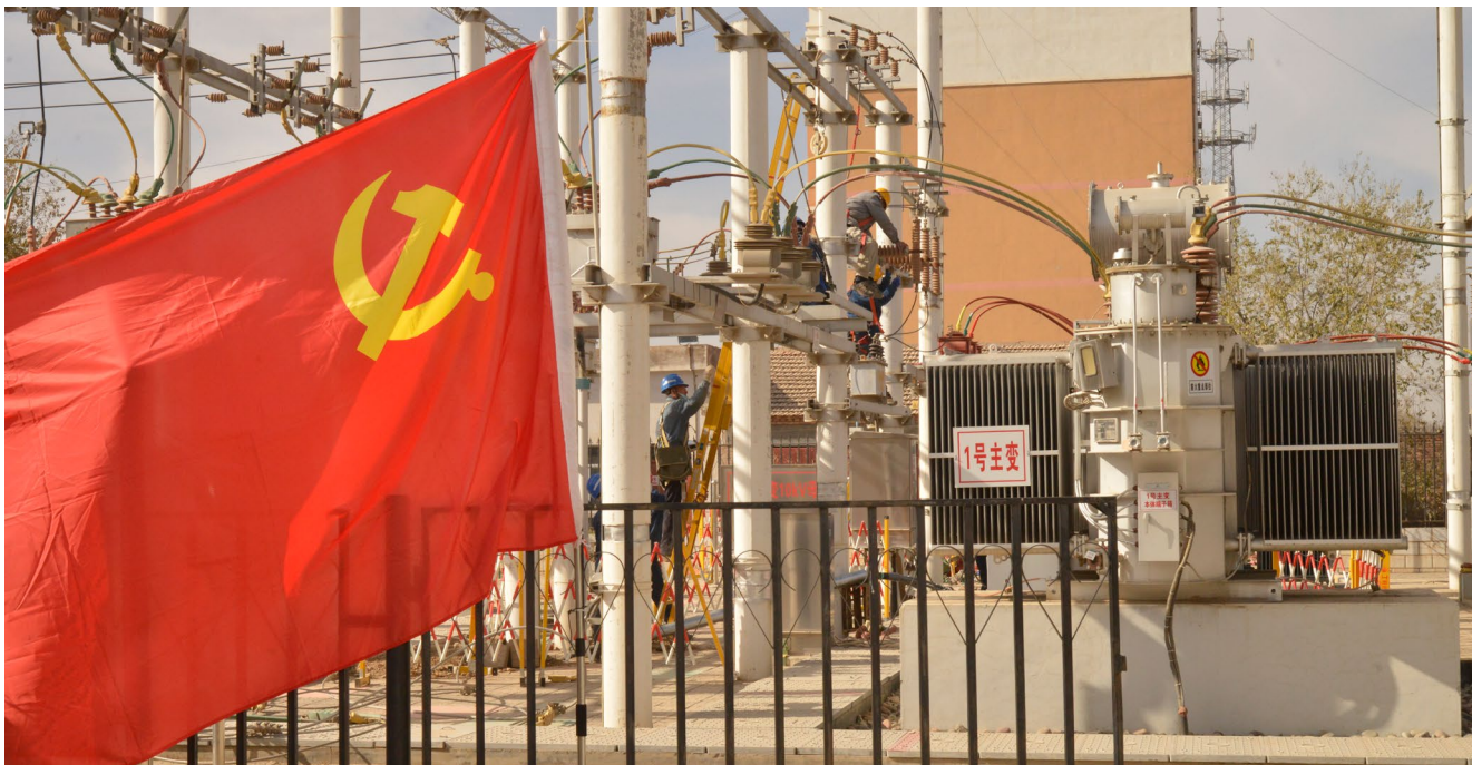
甘州区碱滩镇老寺庙变电站开展检修工作
