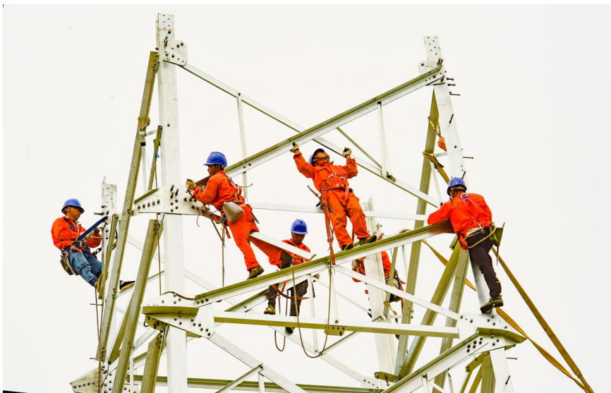
高空组立220 kV安戴线G17号铁塔
