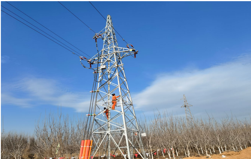
35 kV安周线架空线路电缆入地改造
