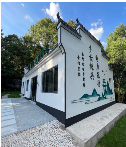
皖南首个乡村数智化电力驿站
