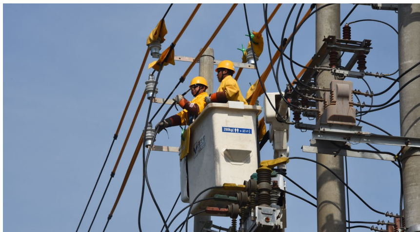
在10 kV丁坊一线进行带电接引流线作业
