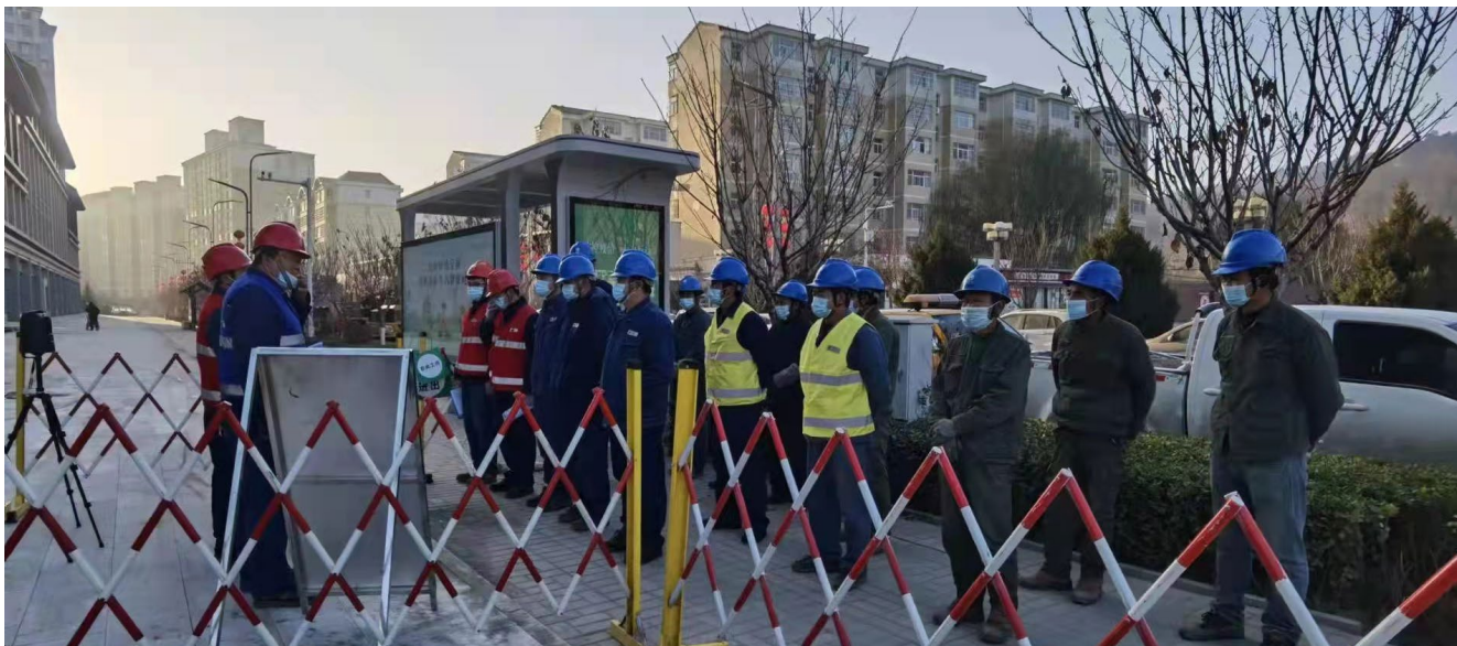
10 kV 177康庄线路环网柜安装作业班前会/张晨佳 摄
