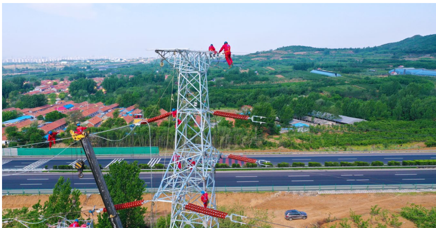
国网临朐供电公司220 kV楼弥线迁改现场
