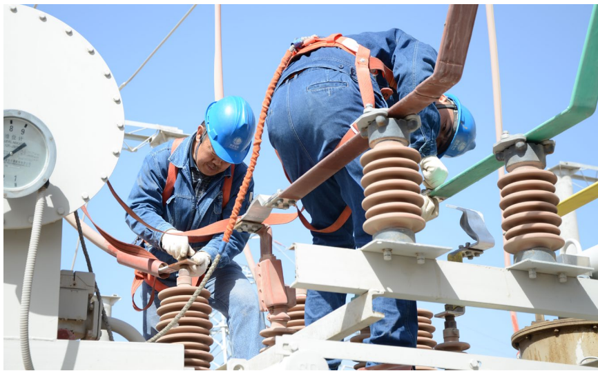
检修人员进行母线安装
