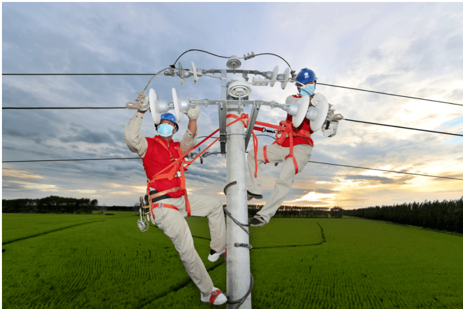
对农村低压线路进行检修
