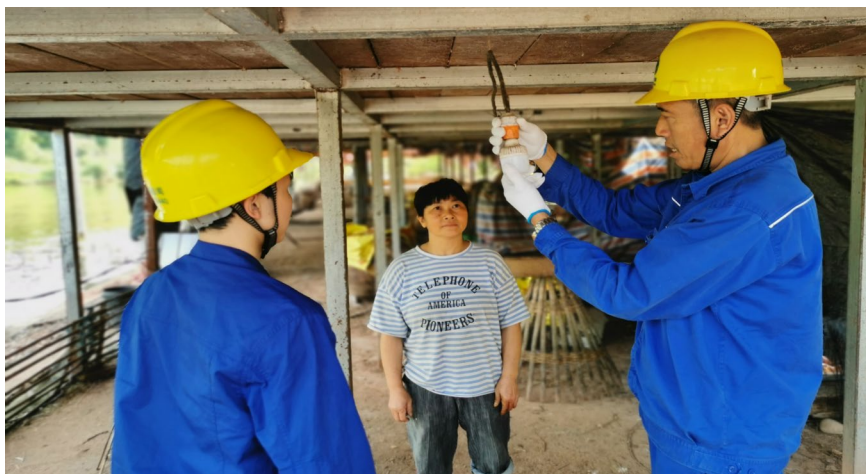
电力员工到入驻村社帮助养殖户检修照明设施
