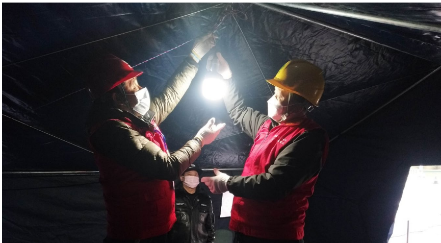
缪小熊为防疫点安装临时电源
