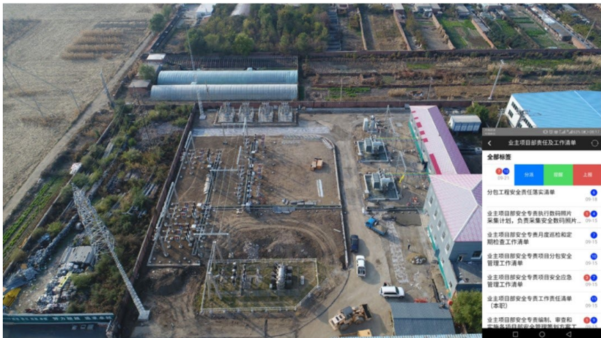
施工现场无人机拍摄图
