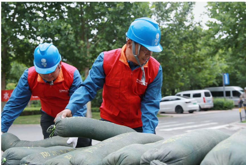
公司员工检修弥河沿岸用电设施
