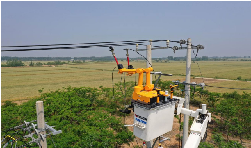
10 kV配网双臂全自主不停电作业机器人带电作业
