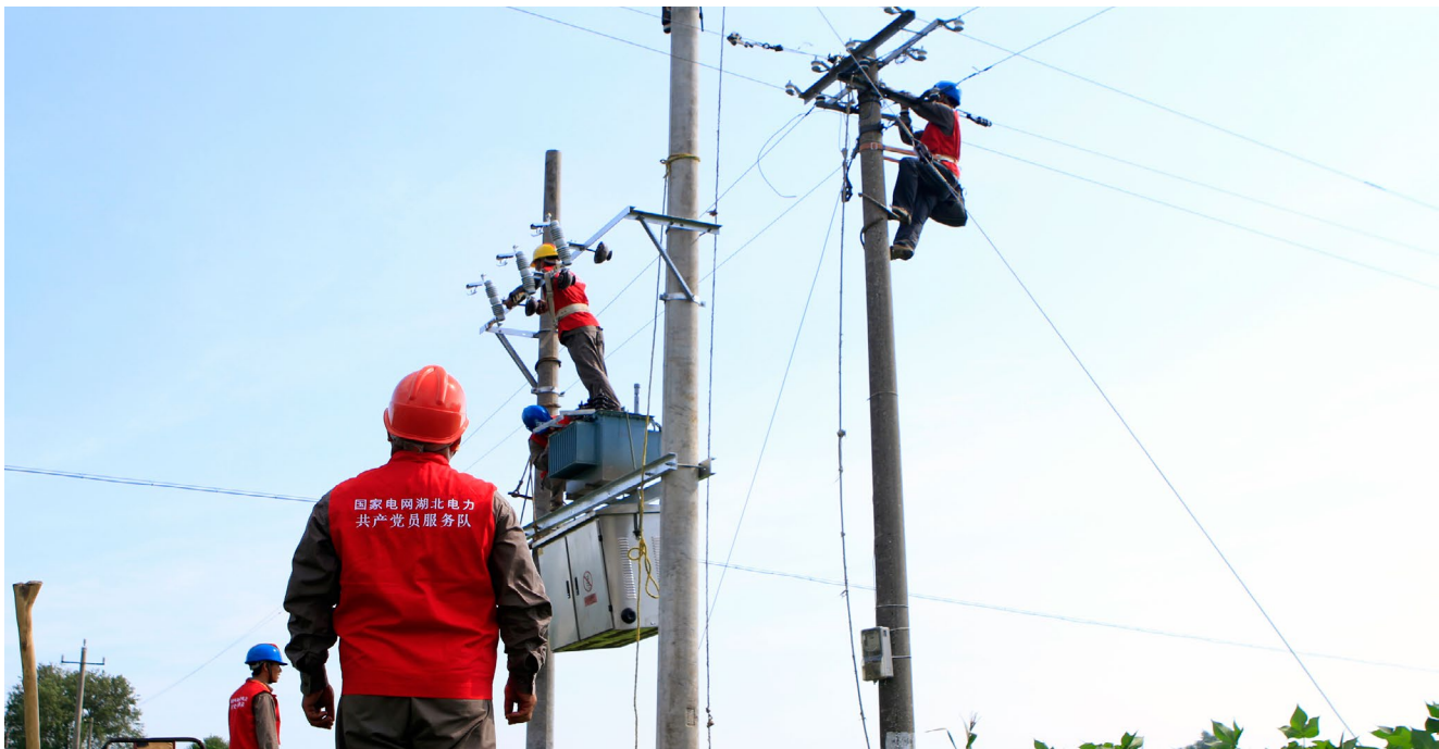
沙洋高阳镇官桥八组改造工程现场
