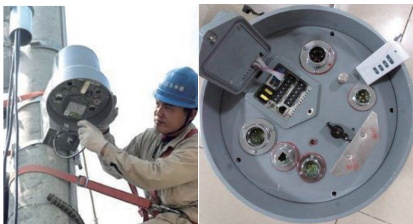
图2 调试传动中某厂家的馈线终端(FTU)
