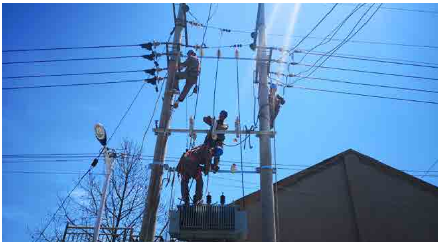
施工人员新架变台、倒切线路
