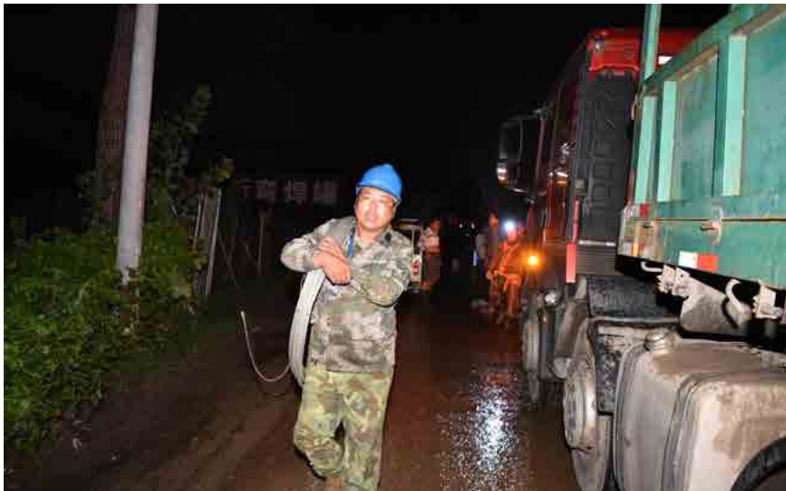
暴雨过后，10 kV石板519线路抢修现场
