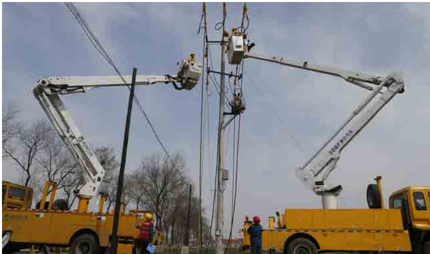
作业人员进行带电线路消缺
