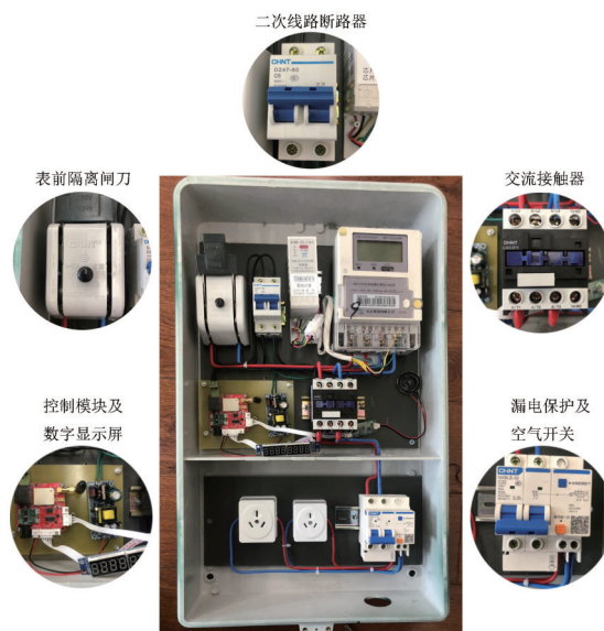
图6 绿色能源箱内部布局图
