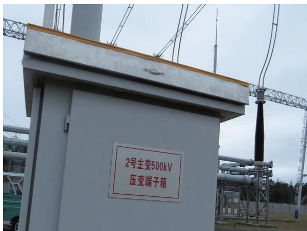
图3 防雨设施现场使用图
