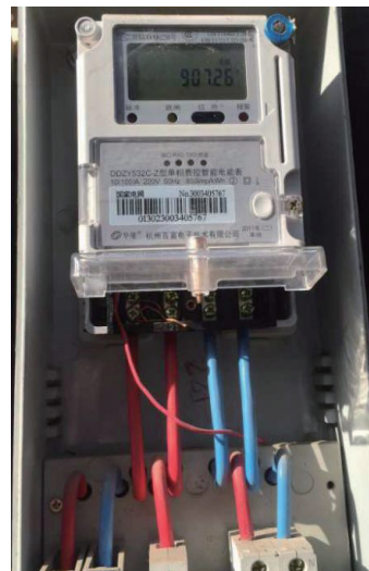
图4 窃电现场绕越计量装置
