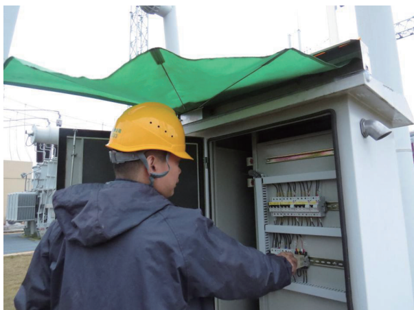
图2 防雨设施现场使用图
