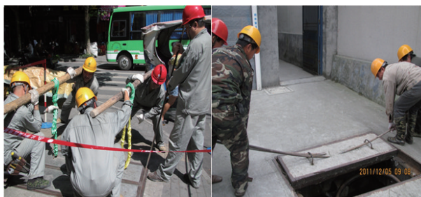
图1 多人合作开启电缆井盖
