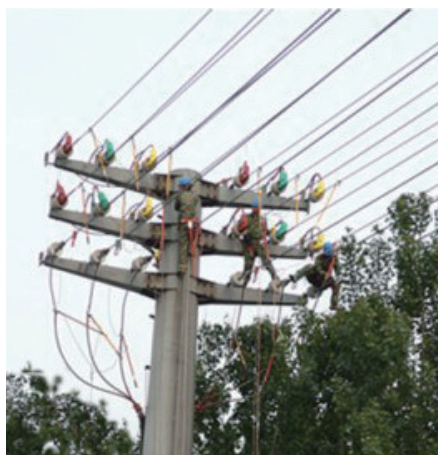
图3 终端杆局部绝缘化防护
