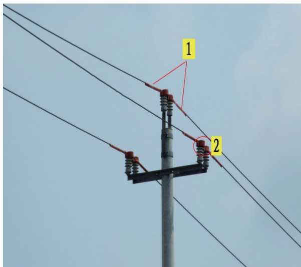
1 为绝缘子两侧绝缘护套; 2 为针式绝缘子护套
