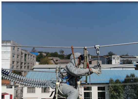
图3 双分裂导线更换或加装间隔棒专用工具现场操作图
