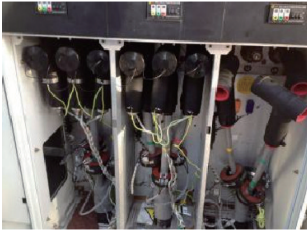
图6 传感器模块现场安装
