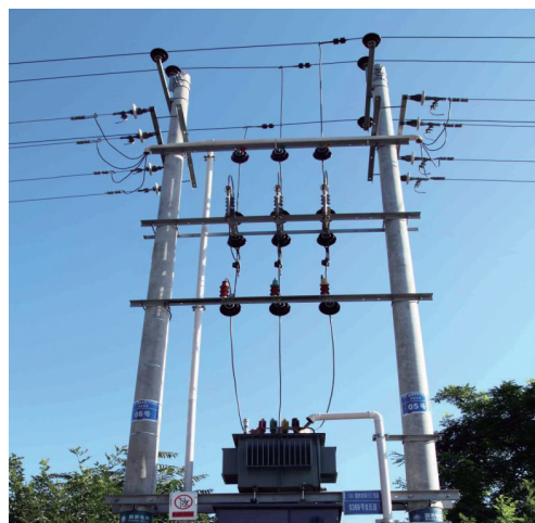
图6 变压器全绝缘防护
