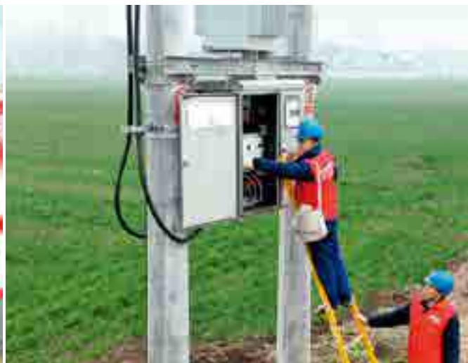
检查配电变压器设施
