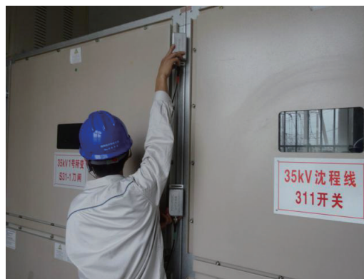
图12 纵向定位传感器布置图
