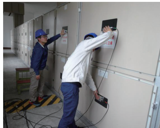
图8 右侧定位传感器布置图
