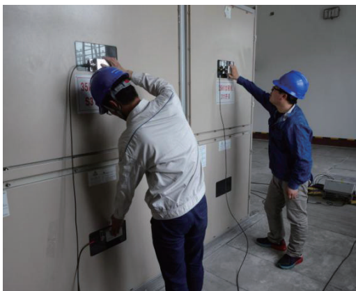
图6 左侧定位传感器布置图
