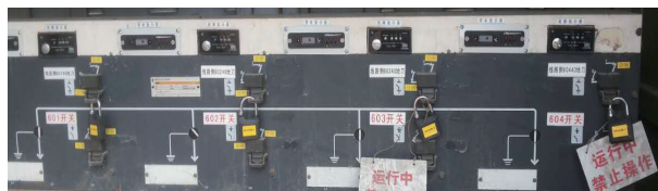
图2 新型带电显示器套上封堵件,在切孔位置安装
