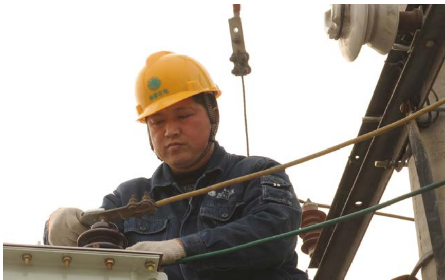
检修配电变压器
