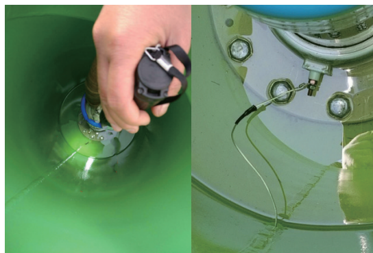
图4 A相套管末屏引线
