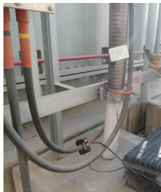
图2 110 kV侧电缆终端局放检测
