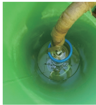
图3 A相电缆连接处
