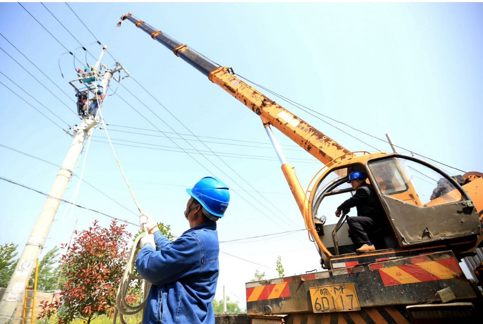
对贫困地区开展电网升级改造/刘晶东 摄
