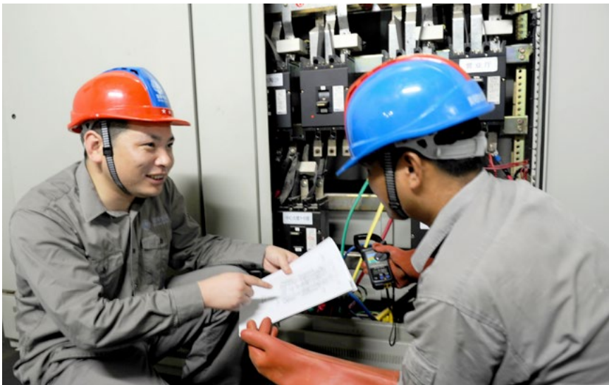
李新民（左）在施工现场进行测试分析
