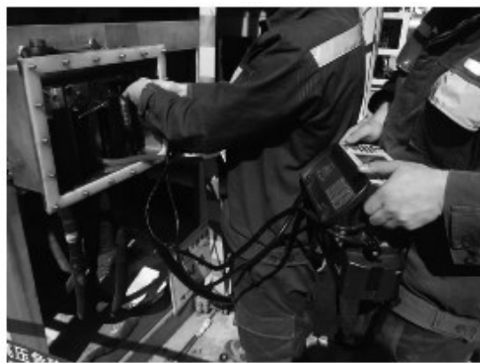
图6 测量接地线线夹及联板接触面间接地电阻 第五,拆除临时引流线,测量修复后的接地线接地电流及各接触面的温度。
