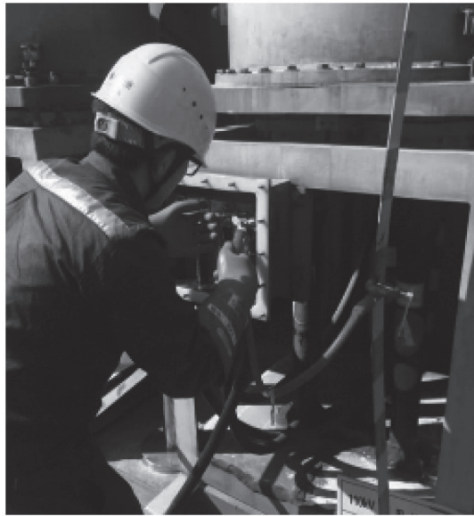
图4 安装临时引流接地线
