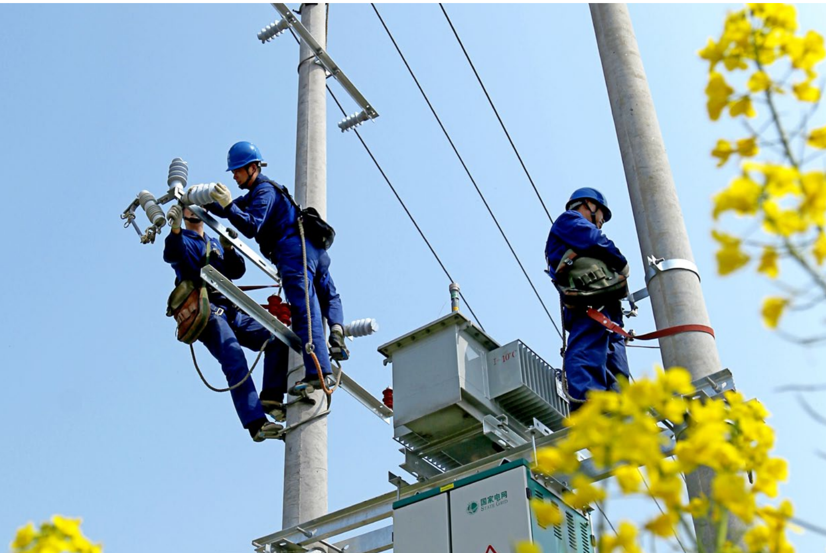
国网四川省电力公司开展农村电网建设
