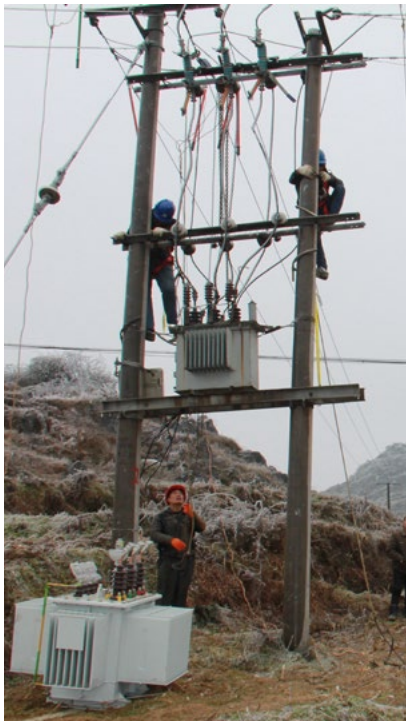
何官屯供电所更换兰家寨变压器
