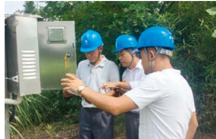
稽查组对高损台区进行现场稽查
