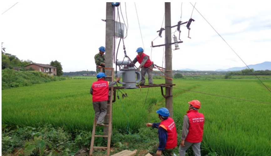
金溪县供电公司专业化队伍在抢修
