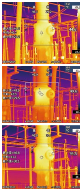
图2 电压互感器A、B、C相电磁单元红外图
