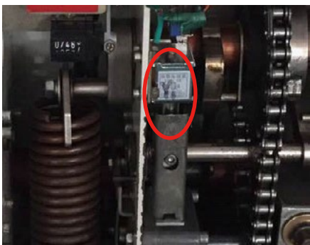
图3 合闸闭锁线圈的机械闭锁
