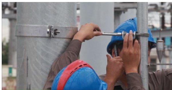
图5 隔离开关机构安装工具应用图
