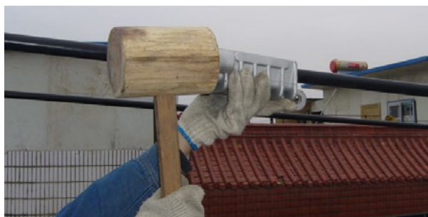
图6 拆除连接器
