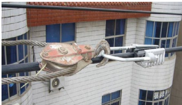
图4 收紧绝缘导线
