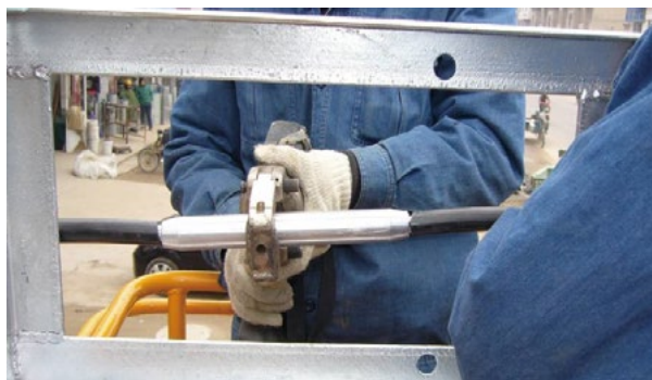
图5 压接绝缘导线
