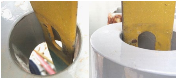
图1 接地引线扁铁与互感器接触情况
