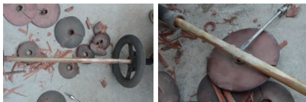
(a) 绝缘子解体后芯棒情况 (b) 发热部分芯棒已粉化
