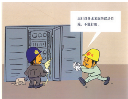
在继电保护装置、安全自动装置及自动化监控系统屏(柜)上或附近进行打眼等振动较大的工作时,应采取防止运行中设备误动作的措施,必要时向调度申请,经值班调度员或运行值班负责人同意,将保护暂时停用。
